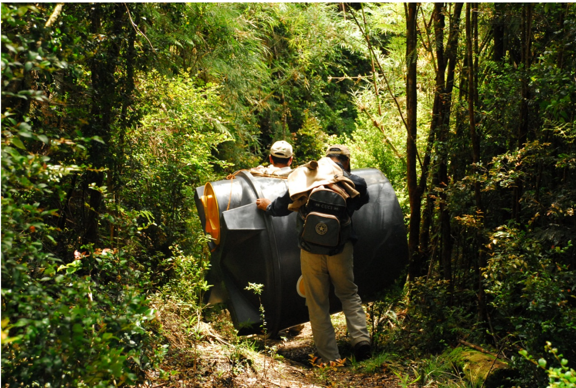
Figura 15. Instalación de un estanque de agua. Gentileza de The Nature Conservancy
