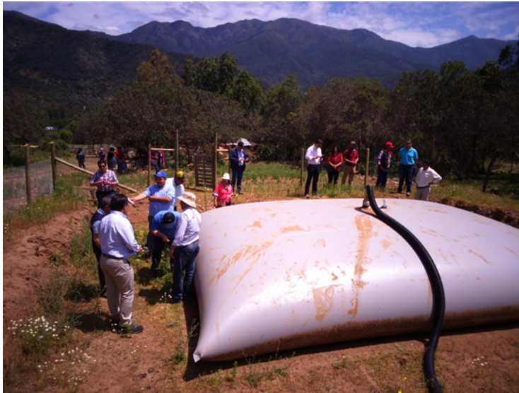
Figura 4. Instalación de cisternas flexibles en la comuna de Alhué. Gentileza de Mario Pinzón.
