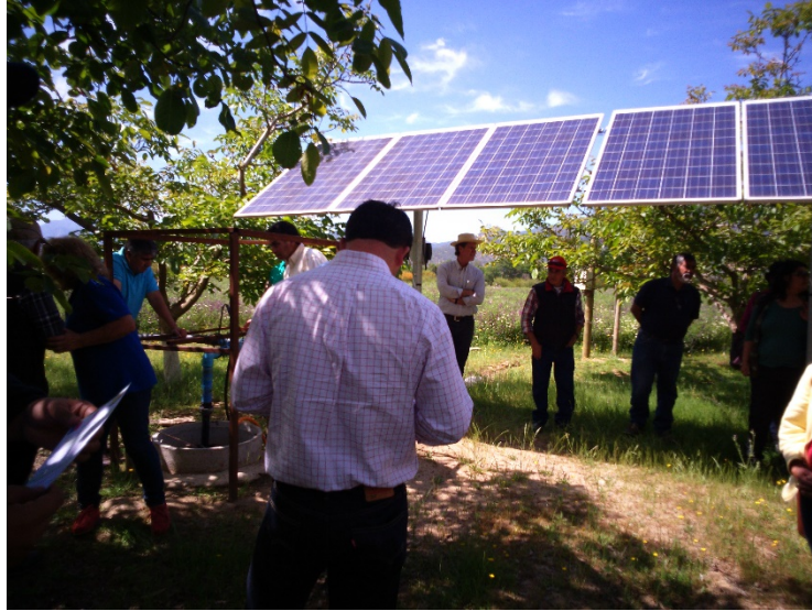
Figura 5. Instalación de paneles fotovoltaicos en Alhué. Gentileza de Mario Pinzón.
