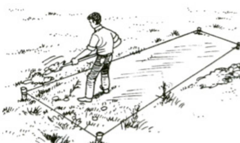
4. Con la pala suelte la tierra del fondo de la zanja, enterrando la pala a 30 cm. Una vez removido el fondo de la zanja, coloque una capa de 10 cm de desechos vegetales
