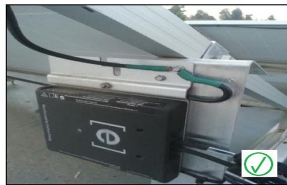
Figura 3-10: Partes metalicas aterrizadas a tierra.
