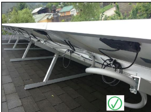
Figura 3-30: Ejemplos de buenas y malas canalizaciones
