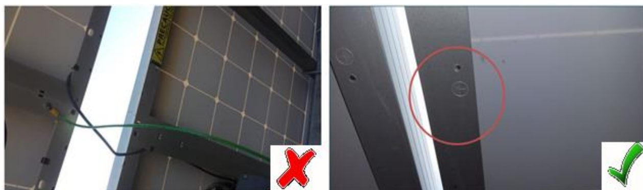
Figura A-6: Bornes para puestas a tierra
