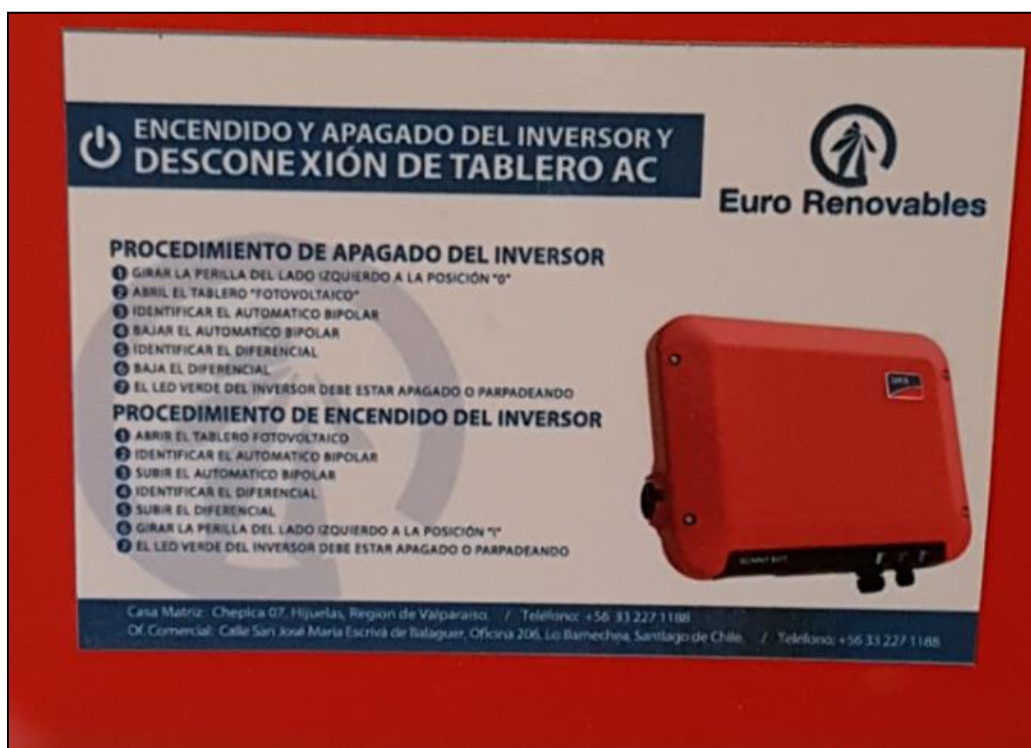
Figura 3-17: Instrucciones para apagar un inversor
